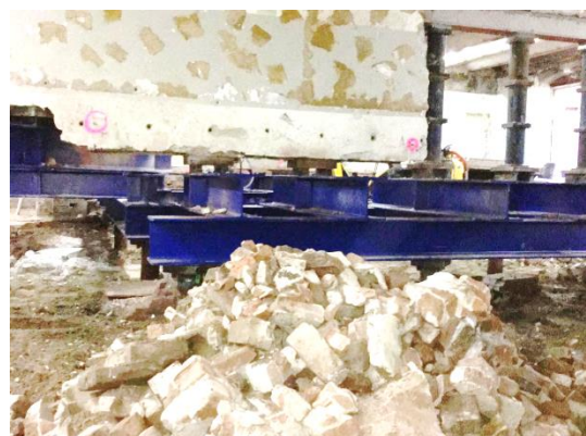
Foto 2: sloopwerkzaamheden onder de gemaakte staalconstructie
