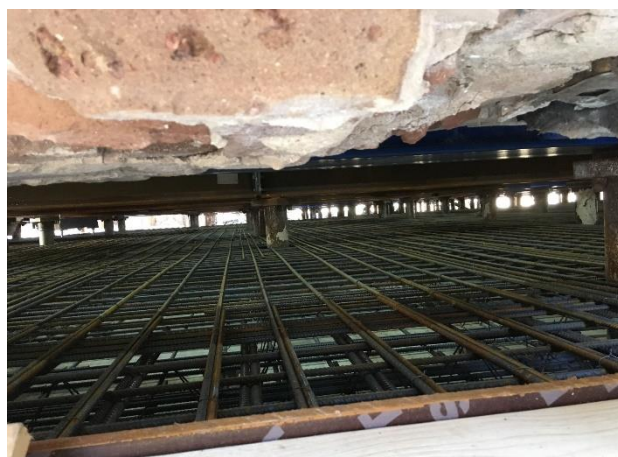
Figuur 1 - Een kijkje onder het UB-pand
