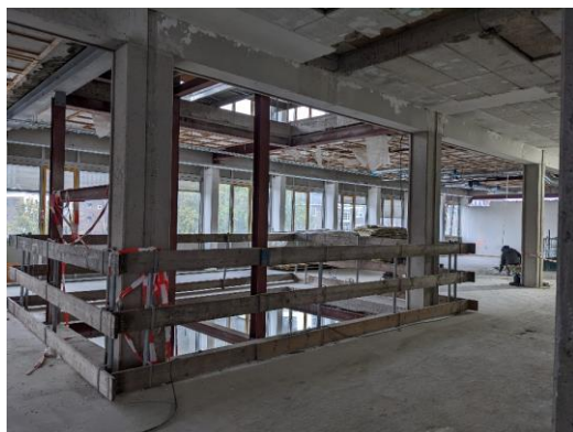
De nieuwe liftschacht, het slopen van de oude liftkern en de lege collegezaal.
