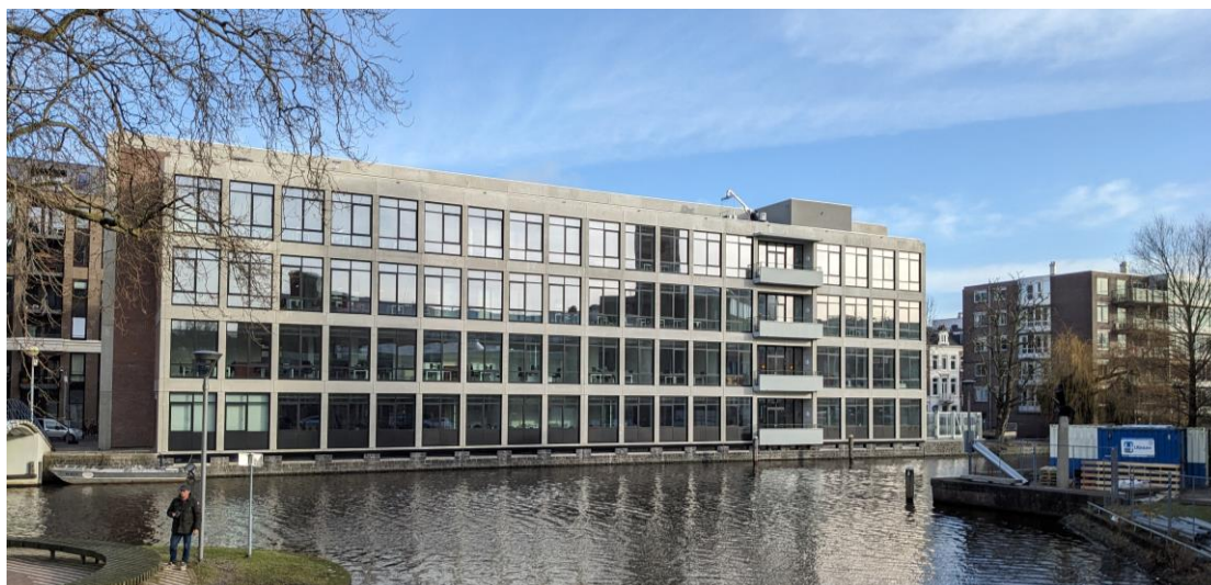
Gebouw REC P is bijna klaar om in gebruik te nemen.
