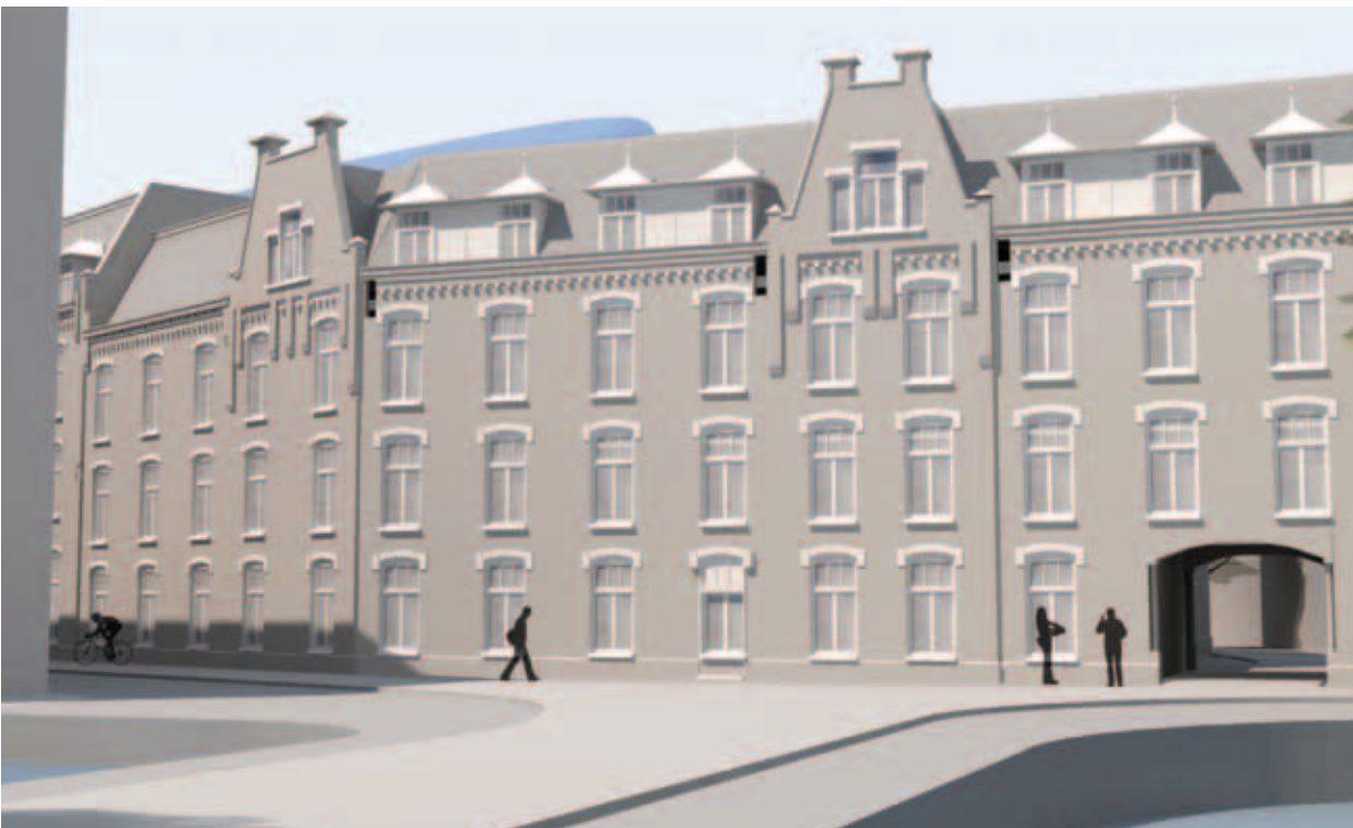
1 Zusterhuis gezien van af brug kruising Staalstraat - Kloveniersburgwal
