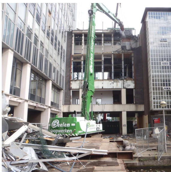
Figuur 2: 50-tons sloopkraan voorzien van lange giek.
