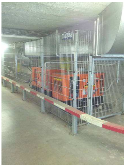
Foto 2: Luchtbehandelingkast in de parkeergarage met uitblaas op dak parkeergarage
